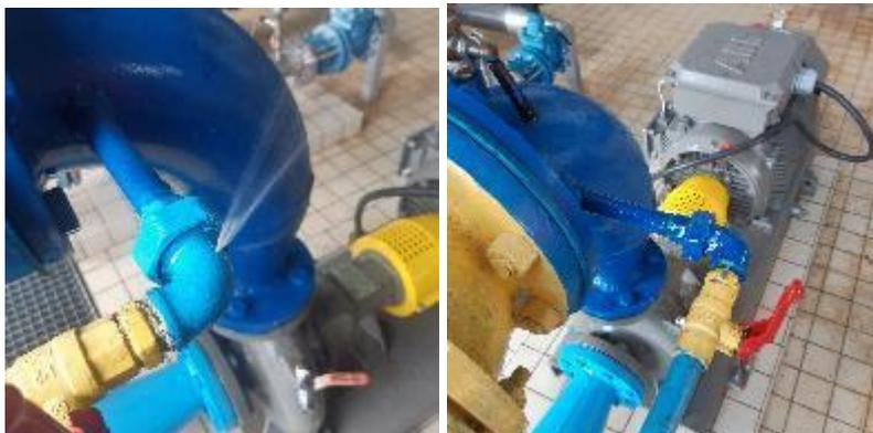
Une autre fuite a été réparée sur la canalisation d'évacuation du filtre 1 de l'unité de production. Régulièrement des fuites sont réparées sur ces canalisations qui deviennent de plus en plus vétustes et de plus en plus fines pour effectuer des soudures. Le renouvellement des tuyauteries les plus fuyardes ou à risques sera envisagé courant 2024.
