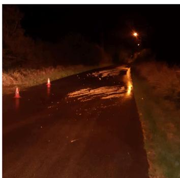
N'ayant pas de vanne pour isoler uniquement cette conduite d'interconnexion avec Savonnières, nous avons profité de la fuite et du remplacement de 2 mètres de tuyau pour en poser une.
