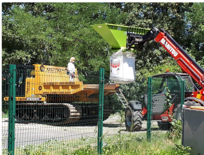
(opération de retrait et d'évacuation des terres polluées et évacuation par un passage à gué)
