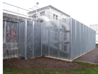
Fermeture garde de corps fosse
