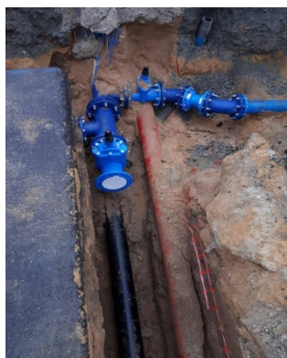
Chantier Tours Centre 2020 : Bouclage air comprimé et renouvellement AEP
