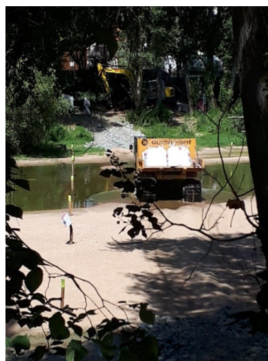
(opération de retrait et d'évacuation des terres polluées et évacuation par un passage à gué)
