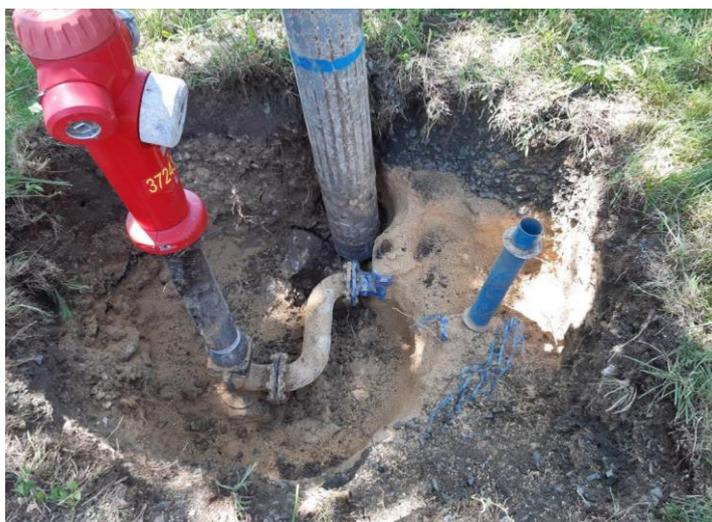
Le terrassement a été réalisé à l'aide d'une aspiratrice qui est particulièrement adaptée aux travaux en milieu urbain. Cette méthode consiste à aspirer les matériaux selon le principe d'un aspirateur industriel au moyen d'une buse fixée sur un flexible. Le terrassement par aspiration permet de réaliser efficacement des travaux d'excavation notamment vis à vis des câbles, canalisations ou encore les racines d'arbres.
