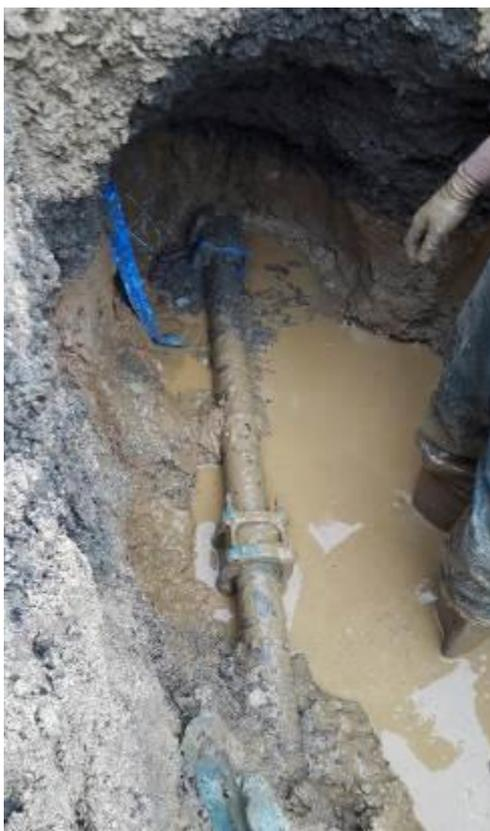
La photo précédente a été prise sur la commune de Rochecorbon le 24/10/2019 au niveau du 47 rue de la Bourdonnière. La fuite se trouvait en bout de réseau sur une conduite en PVC DN 90 mm.
