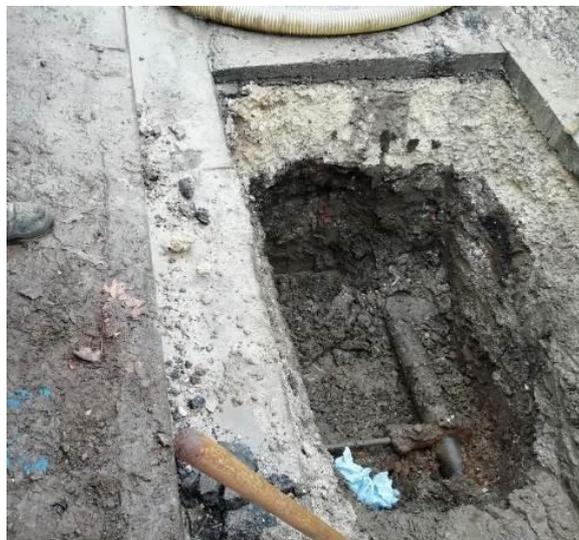
Constatation d'une casse franche sur la conduite en fonte grise DN 100 mm puis réparation :
