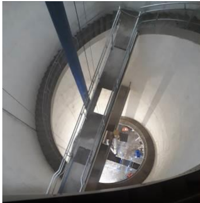
Vue du dessus après enlèvement des colonnes
