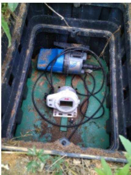
Photo d'une tête de lecture, d'un débitmètre ABB Aquamaster et d'un transmetteur LS42 situés au carrefour de la Marne à Tours Nord
