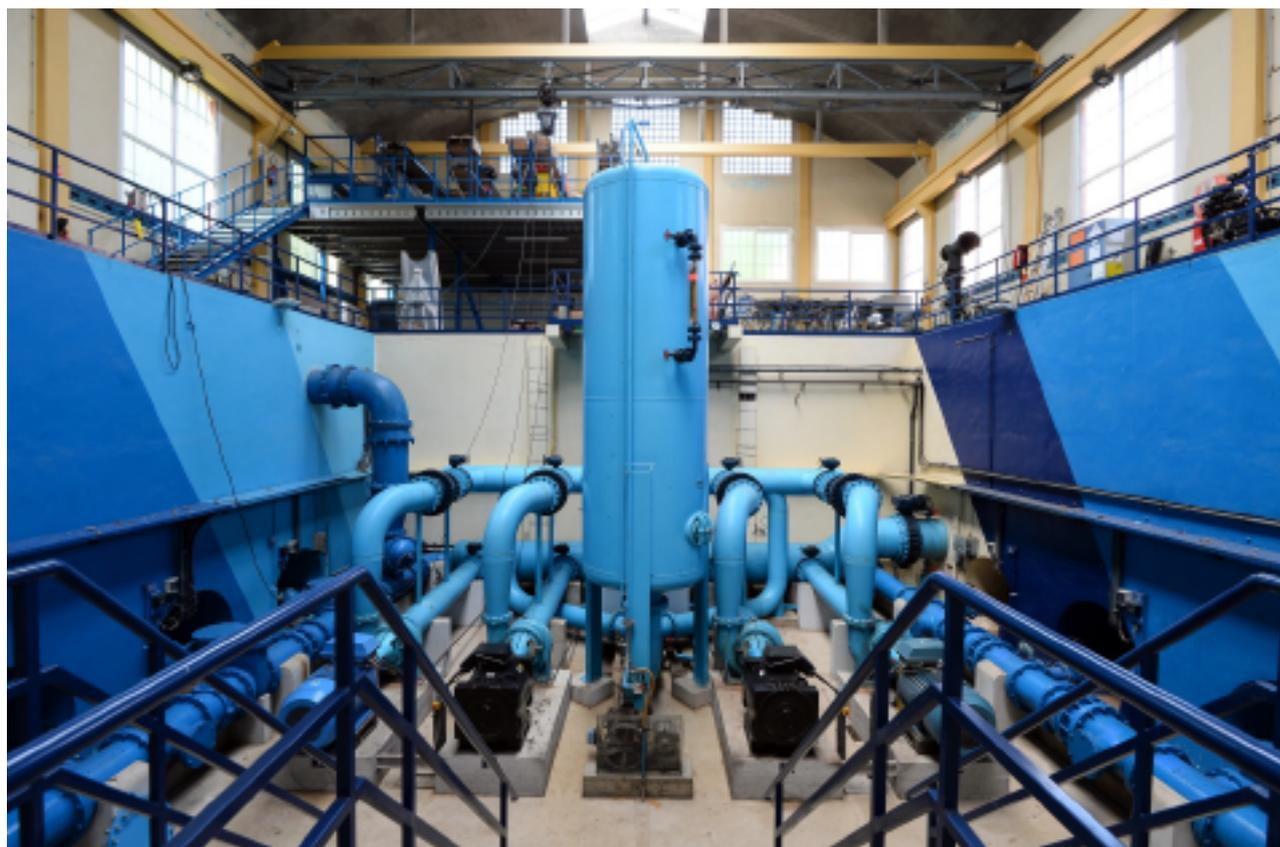
Photo de l'arrivée des puits et de l'anti-bélier de la station de l'île Aucard
