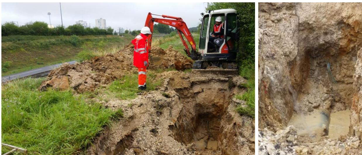
Réparation sur Fonte Ductile DN 250 au forage de la Troue (bord de la rocade) le 27/07/2017
