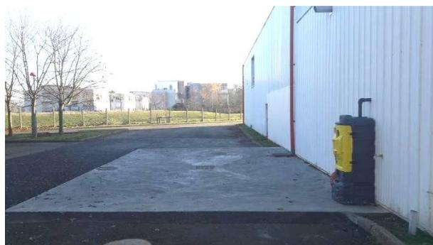
Pose d'un coffret de dépotage sécurisé pour la Soude
