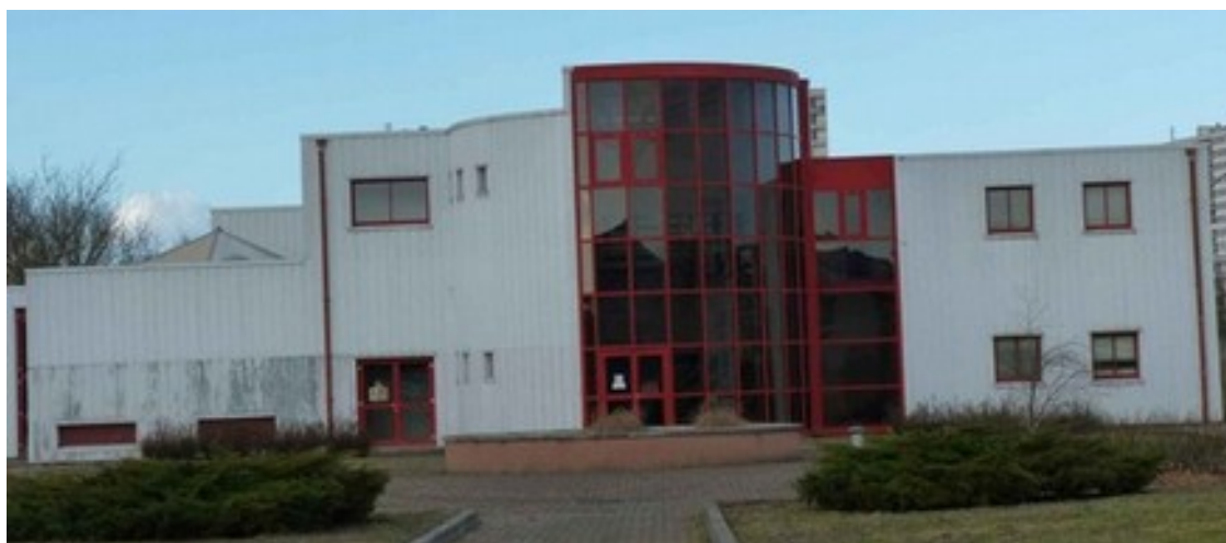
Photo : usine de traitement d'eau potable Pont-Cher
